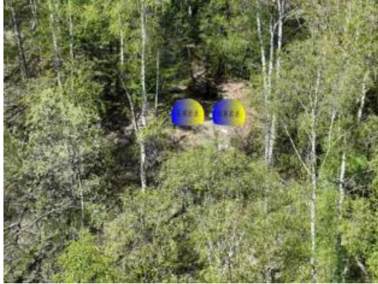
贾登峪 1 号隧道进口照片
